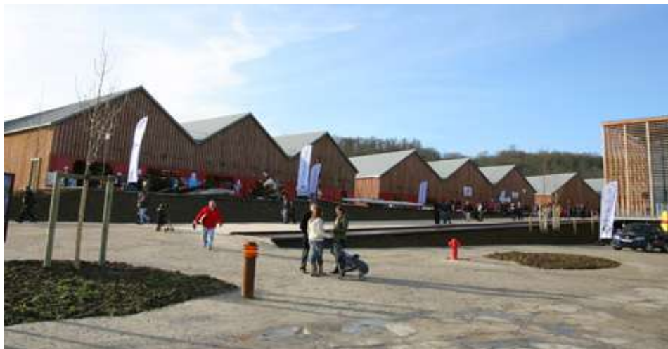
Vue d'ensemble des hangars
