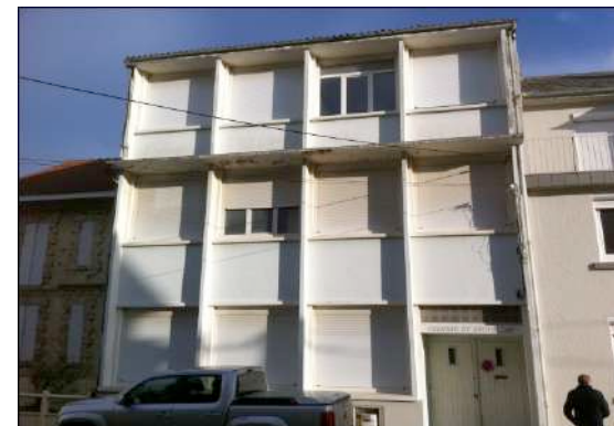
L'ancienne colonie Saint Louis à Fort-Mahon pourrait utilement devenir un hébergement de groupes : bien placé, une rénovation envisageable à prévoir à partir de fondamentaux pré-existants
