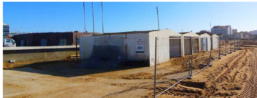
Ancienne base avant destruction
