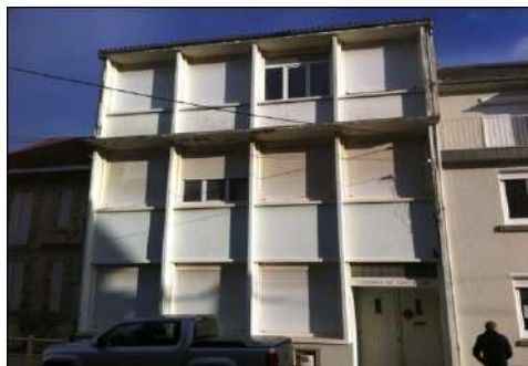
L'ancienne colonie Saint Louis à Fort-Mahon pourrait utilement devenir un hébergement de groupes : bien placé, une rénovation assez facile à réaliser compte-tenu des fondamentaux de la structure.
