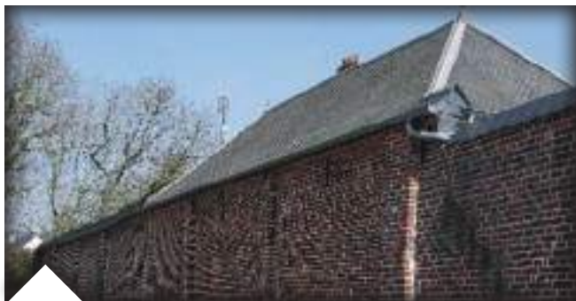
La brique se diffuse à partir du XIX ème siècle. Les nouvelles techniques issues de la révolution industrielle permettent de cuire plus efficacement l'argile. La brique est sombre. Toit en ardoise.
