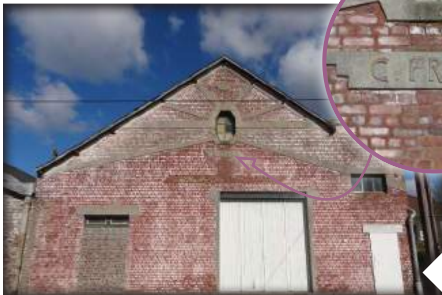
Ancienne usine Priez de robinetterie et de fonderie, rue du 1 er mai. Le pignon porte des éléments décoratifs du style Art Déco, ainsi que l'inscription « 1933 ».
