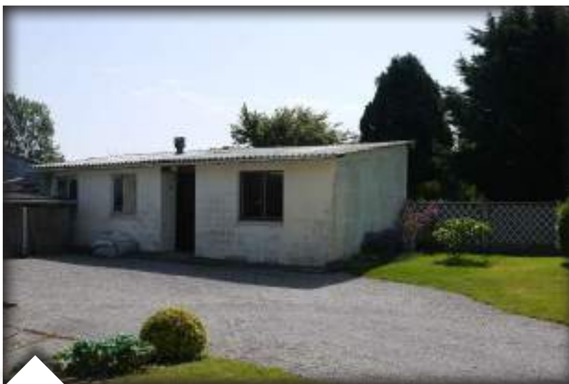
Atelier de polissage d'un sous-traitant pour les usines de robinetterie. Le polissage est une étape de la finition d'une pièce.
