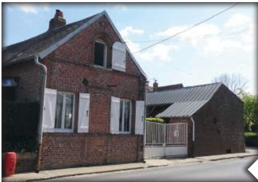
Ancienne usine Quennemont, ancienne fonderie de cuivre, fonderie sable.
