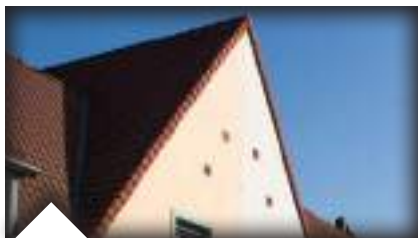
Trous d'aération des combles au niveau du pignon de maisons mitoyennes
