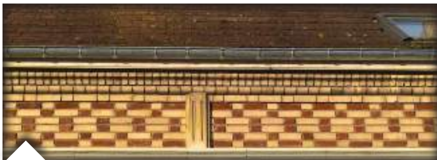
Appareillage décoratif de brique rouge et blanche en bandeau de corniche
