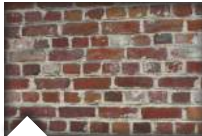
Briques. Appareillage à la française
