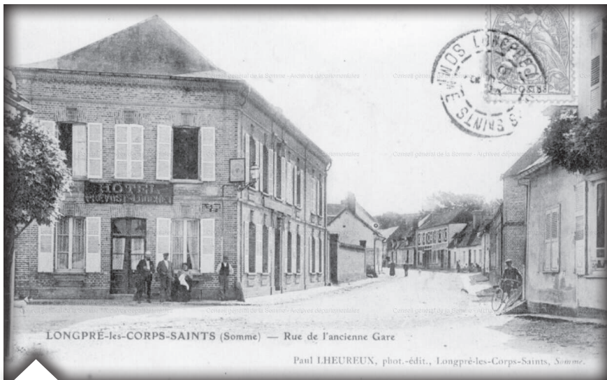
Rue de l'ancienne gare en 1905 8FI3062 - Archives départementales de la Somme. Le tissu bâti est dense et les constructions sont alignées sur la rue.
