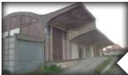
Une halle de stockage à la gare de Longpré-les-Corps-Saints.
