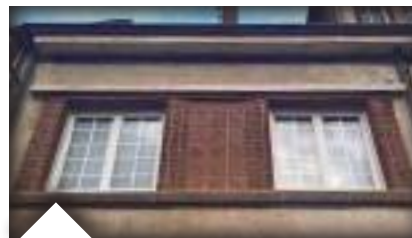
Motifs décoratifs de briques. Fenêtres à petits carreaux
