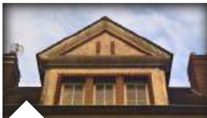
Lucarnes jacobines à fronton triangulaire
