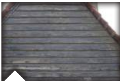
Pignon recouvert de clins de bois horizontaux
