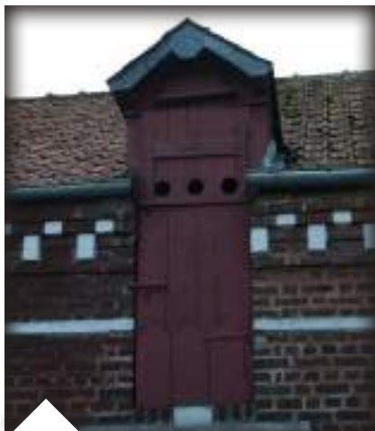
Pigeonnier sur lucarne passante, place de l'église, Noyelles. On distingue les trous d'envols. Ils sont calibrés au plus juste pour empêcher l'entrée des prédateurs.
