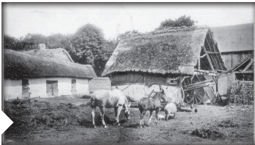
Cour de ferme à Noyelles sur mer. Les constructions étaient en torchis et toits de chaume. AD Somme FRAD080_8FI4644
