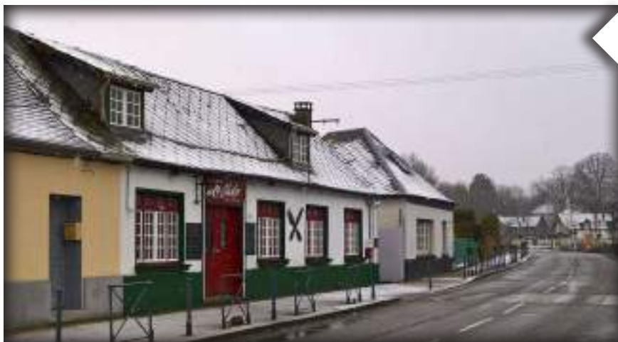
Ancien restaurant et hôtel des voyageurs, actuellement café, 37 rue du Maréchal Foch
