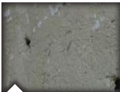
Torchis brut sur le mur d'une grange à Nolette. Dans la partie littorale de la Somme, le torchis est traditionnellement blanchi par un badigeon à la chaux qui protège le torchis brut des intempéries.
