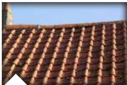
Toiture en pannes picardes de couleur orangée
