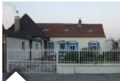
Ancienne ferme 18 rue du maréchal Foch. La dépendance perpendiculaire à la rue a été restaurée en béton de chanvre.
