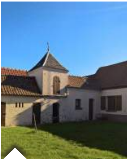
Ancienne ferme. Le logis est en retrait, parallèle à la rue du maréchal Foch. Le bâtiment attenant, perpendiculaire à la rue, comporte un pigeonnier à tour carrée.
