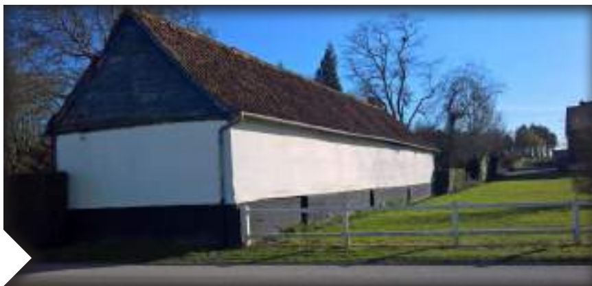
Grange en torchis, à Sailly-Bray. Les constructions à pans de bois et torchis du littoral étaient recouvertes d'un badigeon à la chaux blanc et le soubassement était recouvert de goudron. Ici le pignon comporte un essentage en bois.
