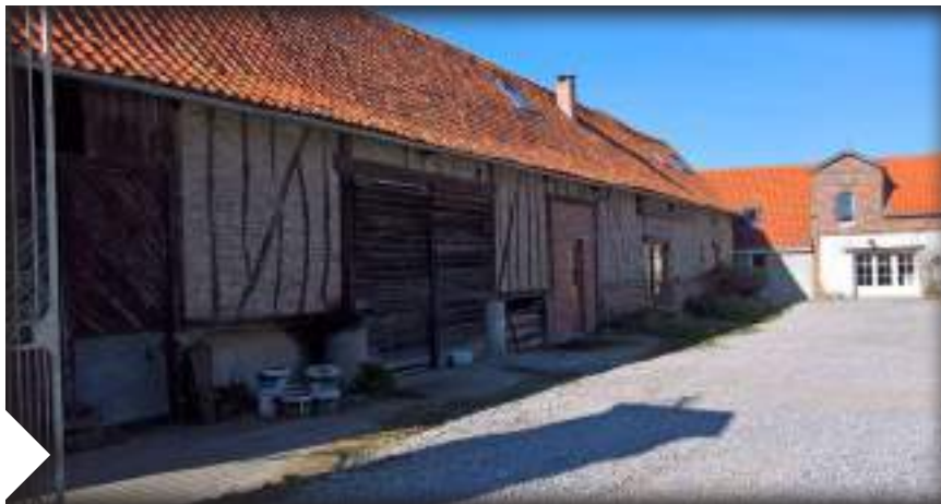
Ferme à Nolette, rue Violette Szabo. Pan de bois à galandage de briques. Traditionnellement les pans de bois étaient recouverts
