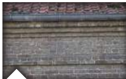
Appareillage de briques du XIX ème . Linteau en saillie et corniche ornementale. Appareillage picard (ou à la française). La brique du XIX ème est couleur lie de vin
