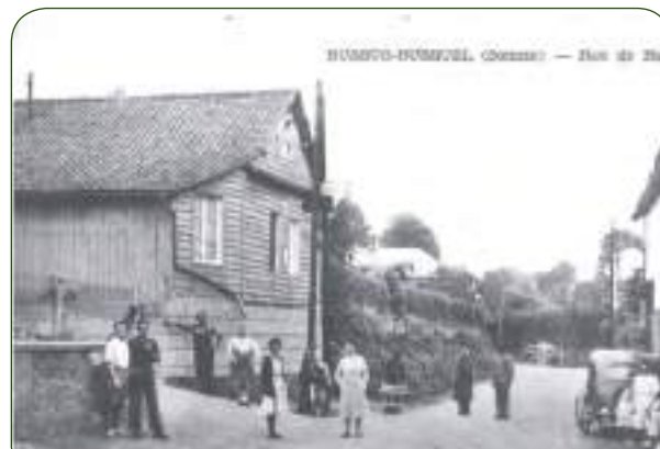
Photo de «ch'bal» (structure en bois qui a été assemblée) Rue du Bas, de gauche à droite :
