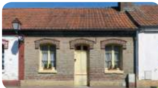
Ancien logement ouvrier de la cité Riquier
