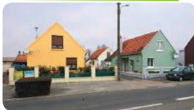
Logements du personnel de l'ancienne usine de cadenas Ancelle-Lecat
