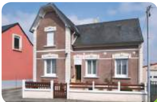
Ancien logement patronal de la fonderie de cuivre Verlant et Beaurain
