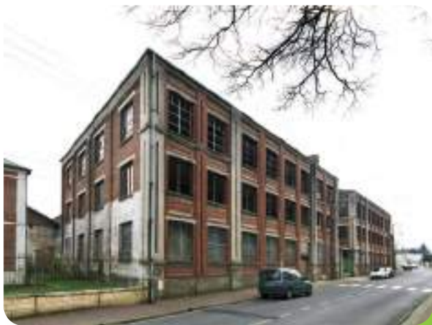
Ancienne usine de serrurerie Bricard (la première usine est détruite par un incendie en 1912)
