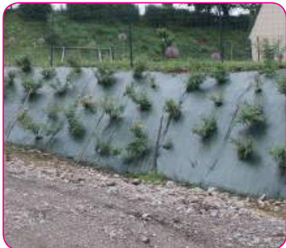
Artificialisation des talus
