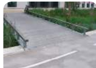
Passerelle vers une mairie
