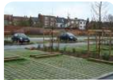
Surface filtrante engazonnée
