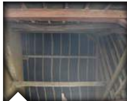
La charpente au-dessus d'une porte charretière
