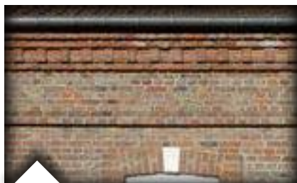
La pierre sert de clef dans le cintre au-dessus de la fenêtre.
