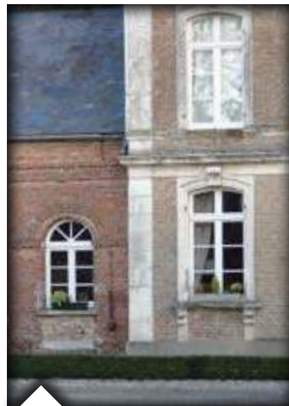
La pierre est présente en chaînage d'angle, en encadrement de baie.
