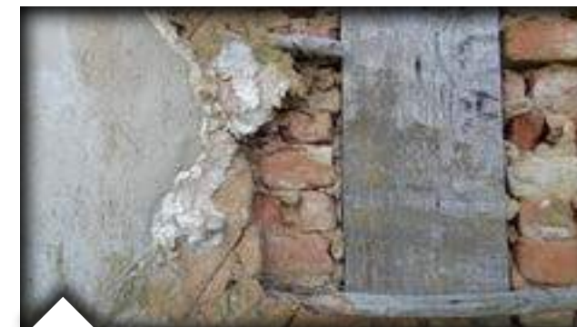
Construction à pan de bois, remplie de torchis et de briques
