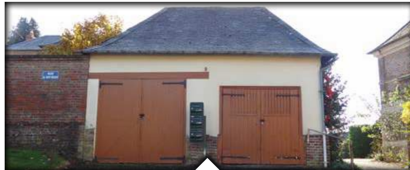
Bâtiment pour abriter le corbillard et la pompe à incendie devant l'ancien presbytère. A quatre pans, il est couvert en ardoises et construit en briques.
