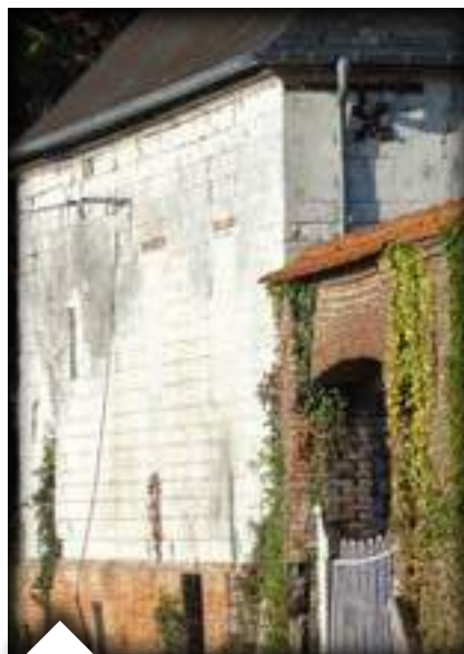
Mur en pierre calcaire.
