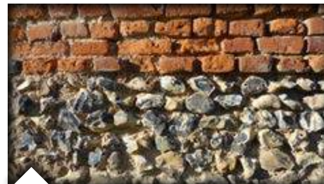
Mur en brique ancienne et silex non taillé
