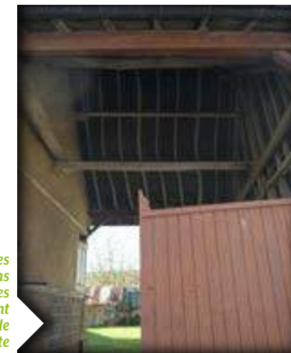
Bâtiment pour abriter le corbillard et la pompe à incendie devant l'ancien presbytère. A quatre pans, il est couvert en ardoises et construit en briques.
