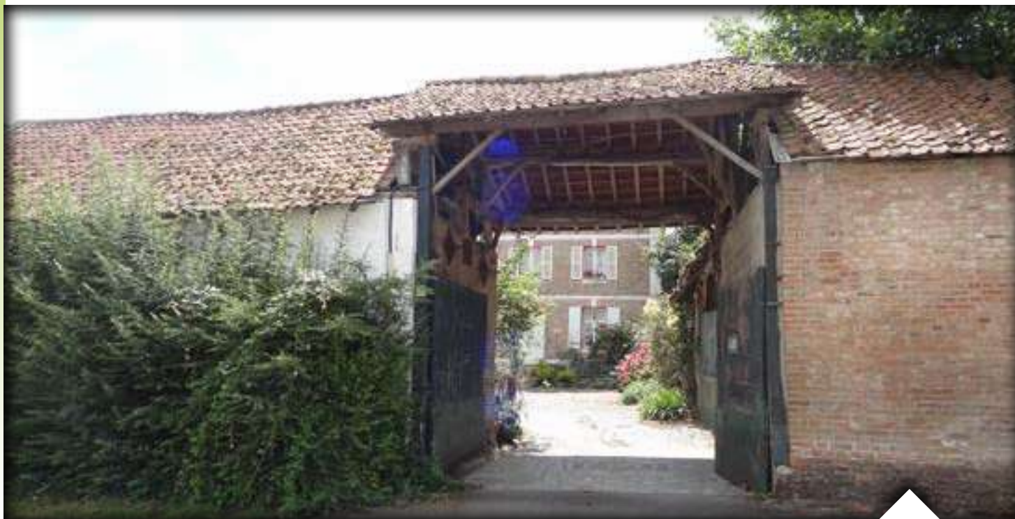
La porte charrière, est entièrement intégrée à la grange sur rue, rue de l'église. La « cartrie » abrite les charrettes.
