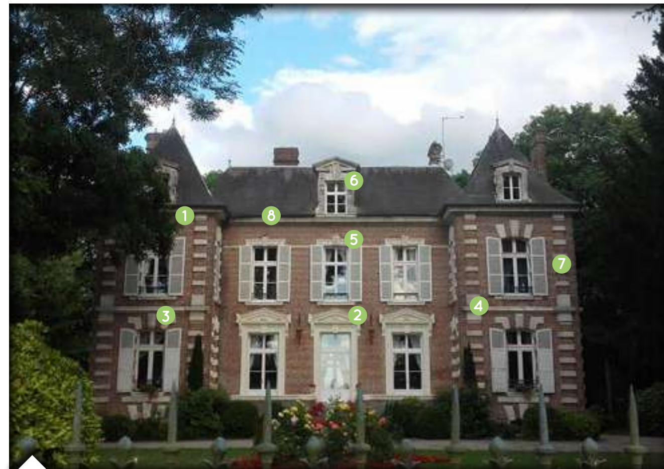
Maison de maître rue de l'Eglise. XIX ème siècle. C'est une maison de maître sur deux niveaux et combles. Ici, la pierre calcaire est utilisée comme ornementation sur la façade de briques.
