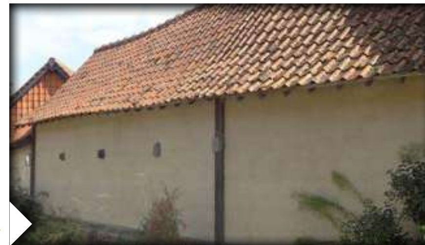
Exemple d'enduit imitation torchis sur l'entièreté d'un mur.
