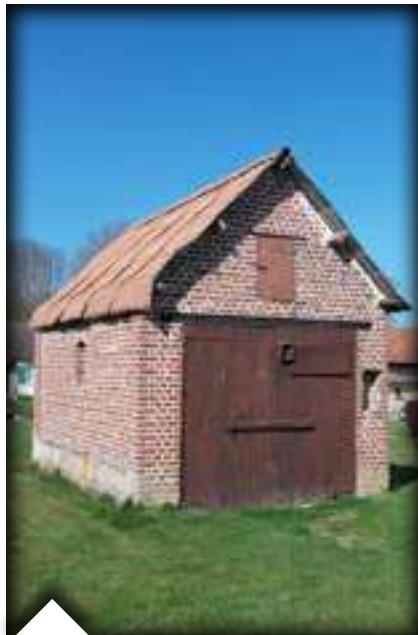
« Garage » de la pompe à incendie au Plouy, à côté de la mare publique. Il fut construit en 1927 par la commune.
