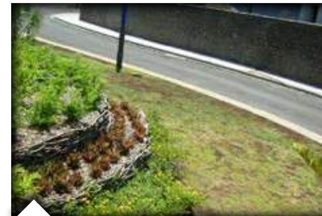
Fascines et vivaces
