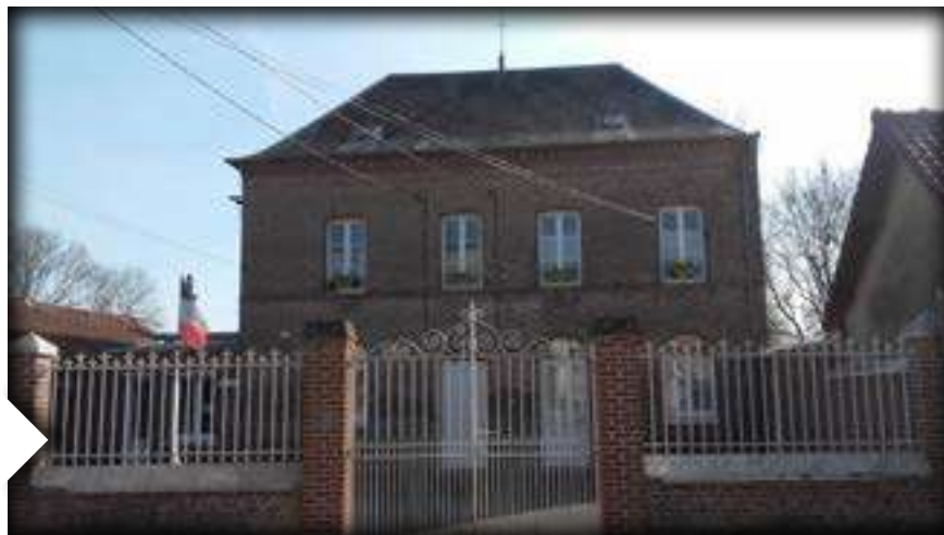
L'école des garçons construite en 1859 est devenue la mairie. Route du Plouy.
