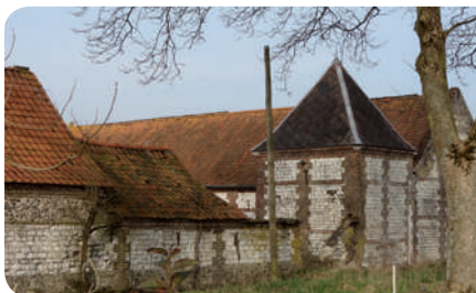
Ferme sur RD1001
