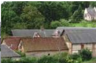
Corps de ferme rue du Bas
