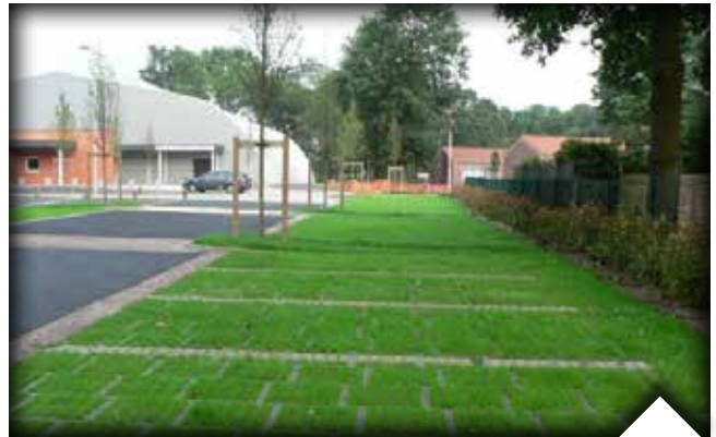
Le stationnement sur du gazon arme permet une infiltration des eaux et un reverdissement du cœur de village.
