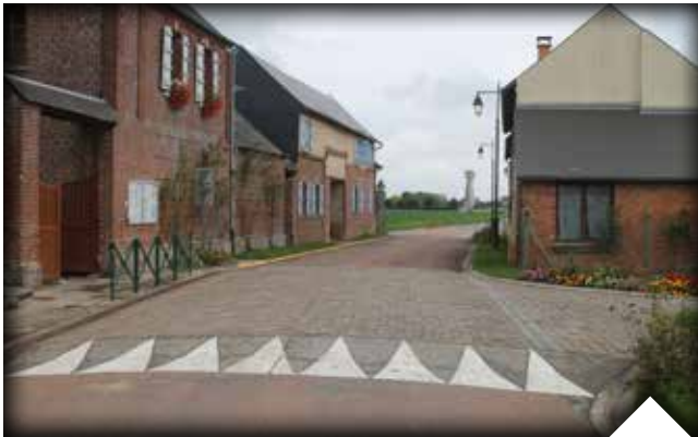
Revêtement traditionnel en pavé de grès au niveau du carrefour.
