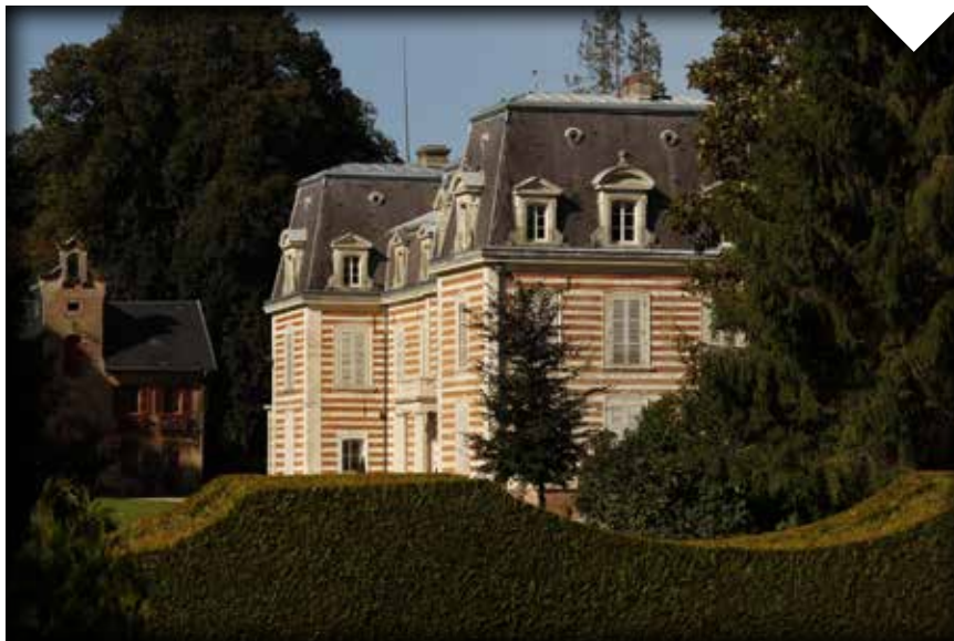
façade sud actuelle du château
