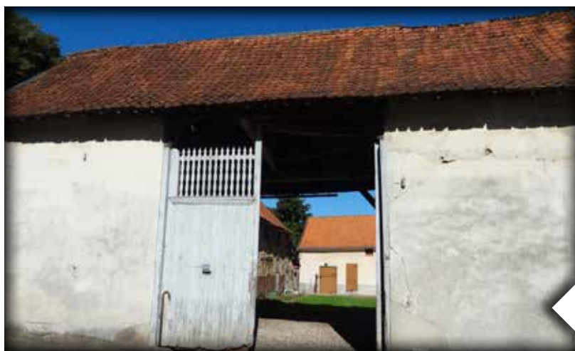
ferme rue de Frières
