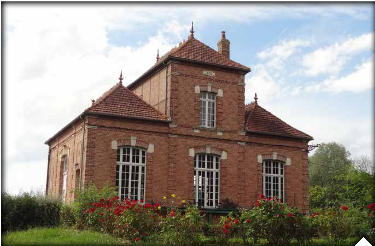
L'usine hydro-électrique : le bâtiment est construit en briques et repose sur pilotis. Le rez-de-chaussée est constitué d'une seule pièce éclairée par six grandes baies. Il a été inauguré le 7 juin 1903.
