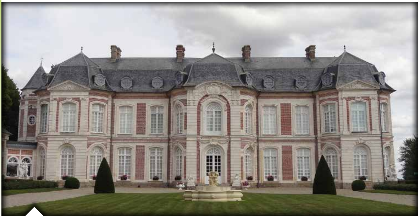
La façade brique et pierre du Château de Long
