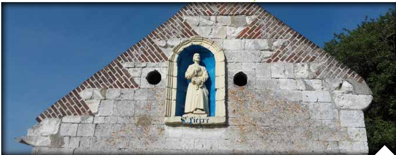
Oratoire creusé dans le mur d'une grange privée, rue de la Cavée, élément très présent dans le paysage urbain
