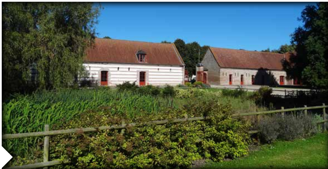
Vue actuelle de la cour et des dépendances du Grand-Mezoutre
