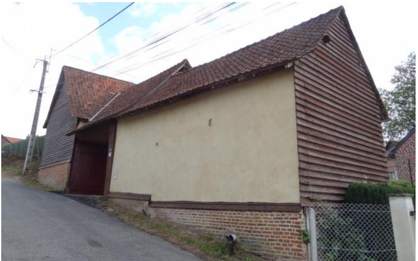
Figure 92 : Grange en torchis réhabilitée à Huchenneville - Source : Baie de Somme 3 Vallées
